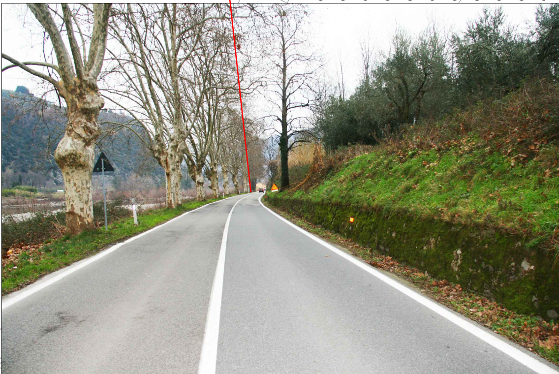
Foto 2, in direzione di Borgo a Mozzano
